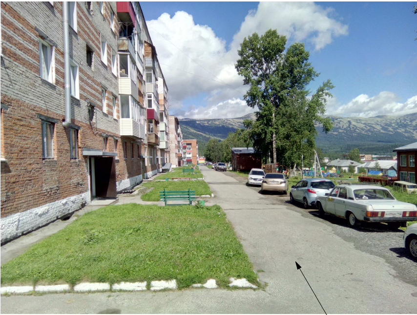
Рассматриваемая придомовая территория под капитальный ремонт
